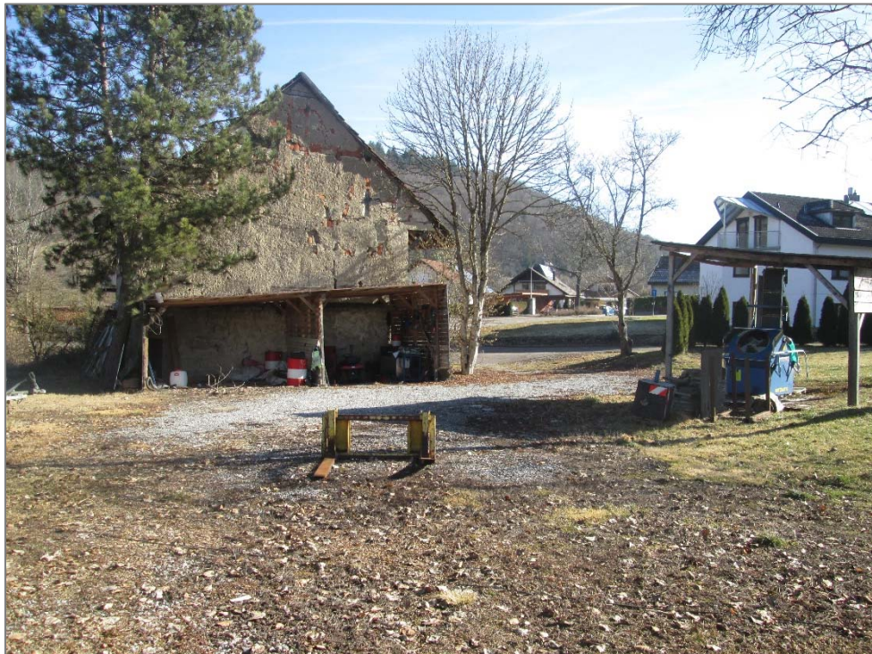
Abbildung 8: Offene Unterstände als Scheunenanbau, zu Lagerzwecken sowie freistehend, zum Schutz der Kreissäge; Blick nach Norden (Foto: HPC AG, 26.02.2019)
