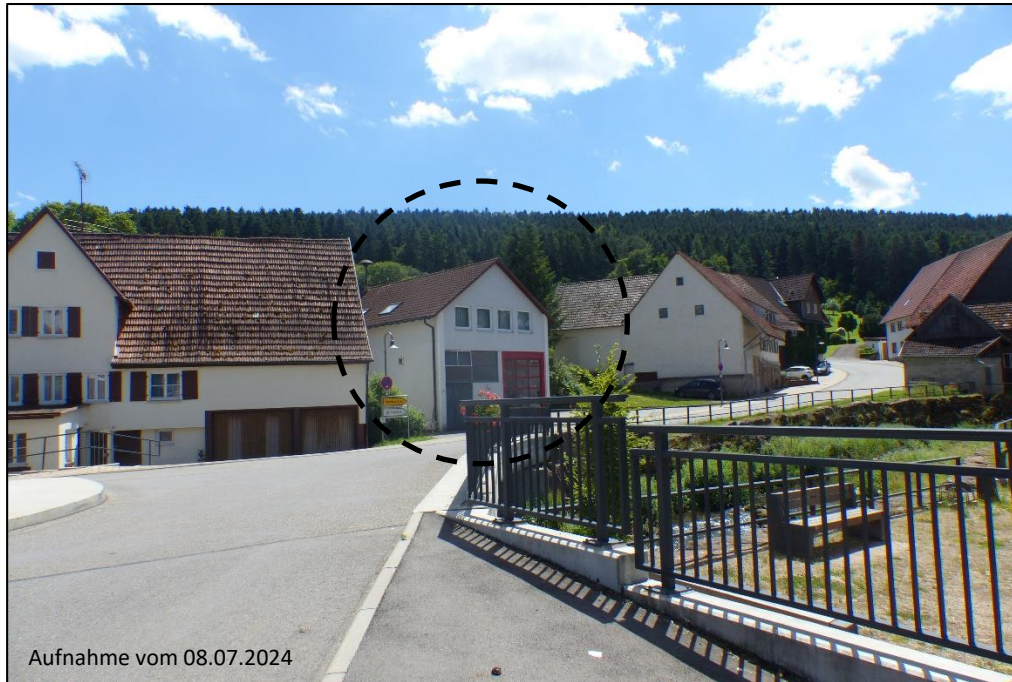
Abbildung 4 – Westansicht des Feuerwehrhauses
